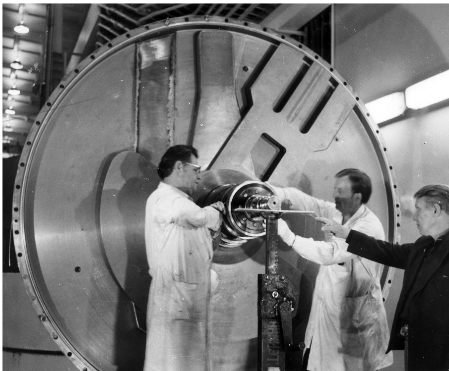
Сборка подвижного отражателя ИБР-2 на стенде
