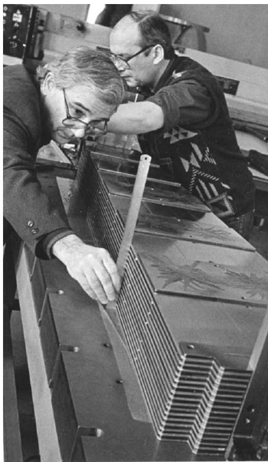
Рис. 8. Склейка одного из четырех субмодулей для модуля-0. Март 1996 г. ЛЯП ОИЯИ.
